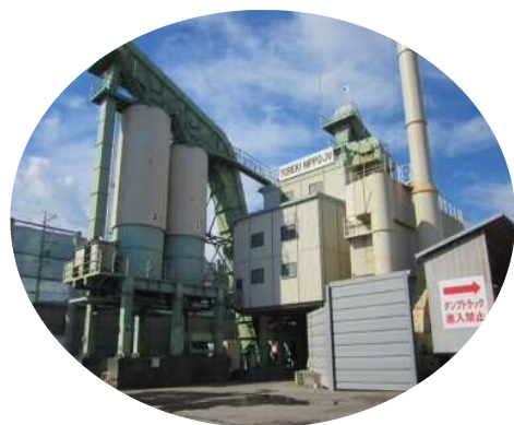
アスファルトプラント
