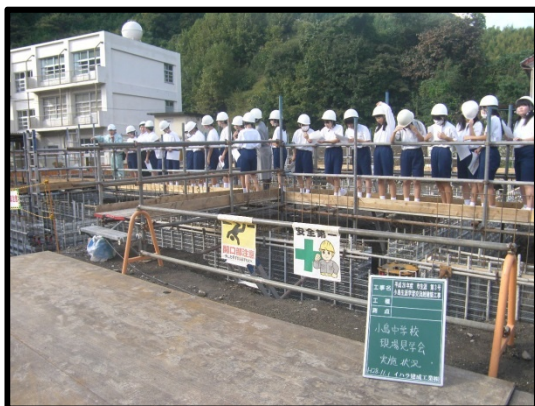
中学生に建設現場を見てもらいました
