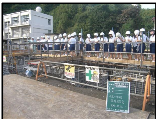
中学生に建設現場を見てもらいました
